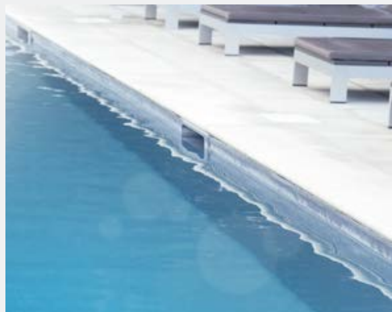
Soudure au-dessus du niveau d'eau garantissant l'absence de fuite.
